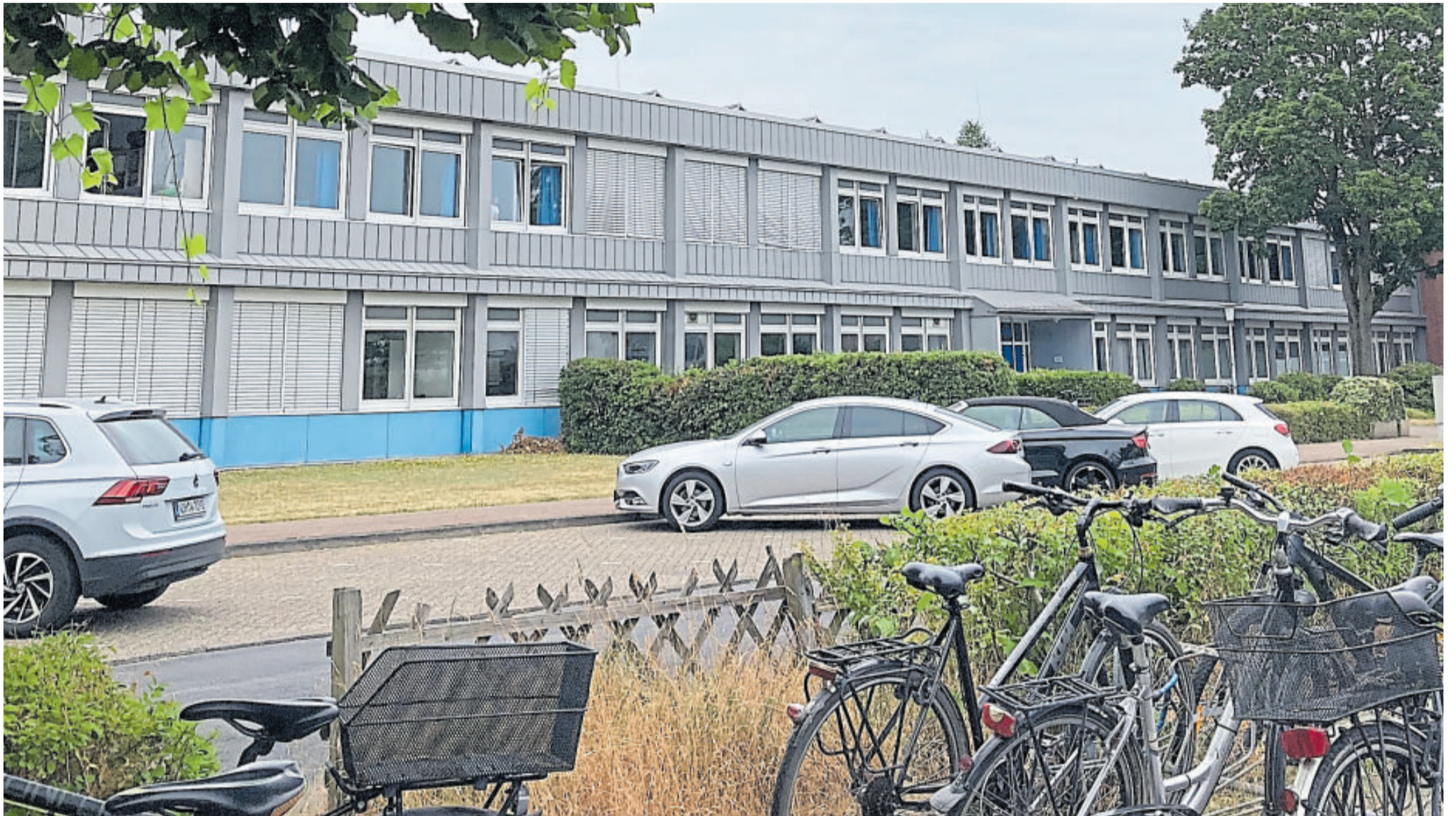
Nicht nur die Aula: Das gesamte Schulgebäude soll saniert werden.
